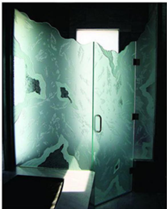
از درب های شیشه ای می توان در حمام استفاده کرد که به صورت درب شیشه ای جلوی وان و شیشه دور دوش با يراق الات استنليس استیل استفاده می شود و مانع از پاشیده شدن آب به دیگر بخش ها می شود .
